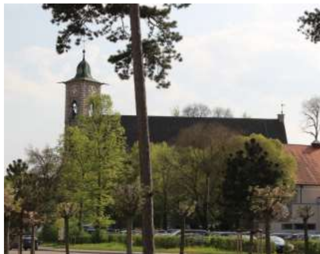
Bild: Die Martin-Luther-Kirche grüßt auch nach neunzig Jahren – äußerlich fast unverändert – an der Zinglerstraße 66 die Ulmer Weststadt. Hier ein Blick vom Ehinger Tor nach Süden.
